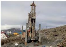
山地打孔施工 Mountain drilling
