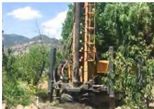
山地打孔施工 Mountain drilling
