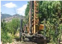
山地打孔施工 Mountain drilling
