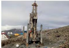
山地打孔施工 Mountain drilling
